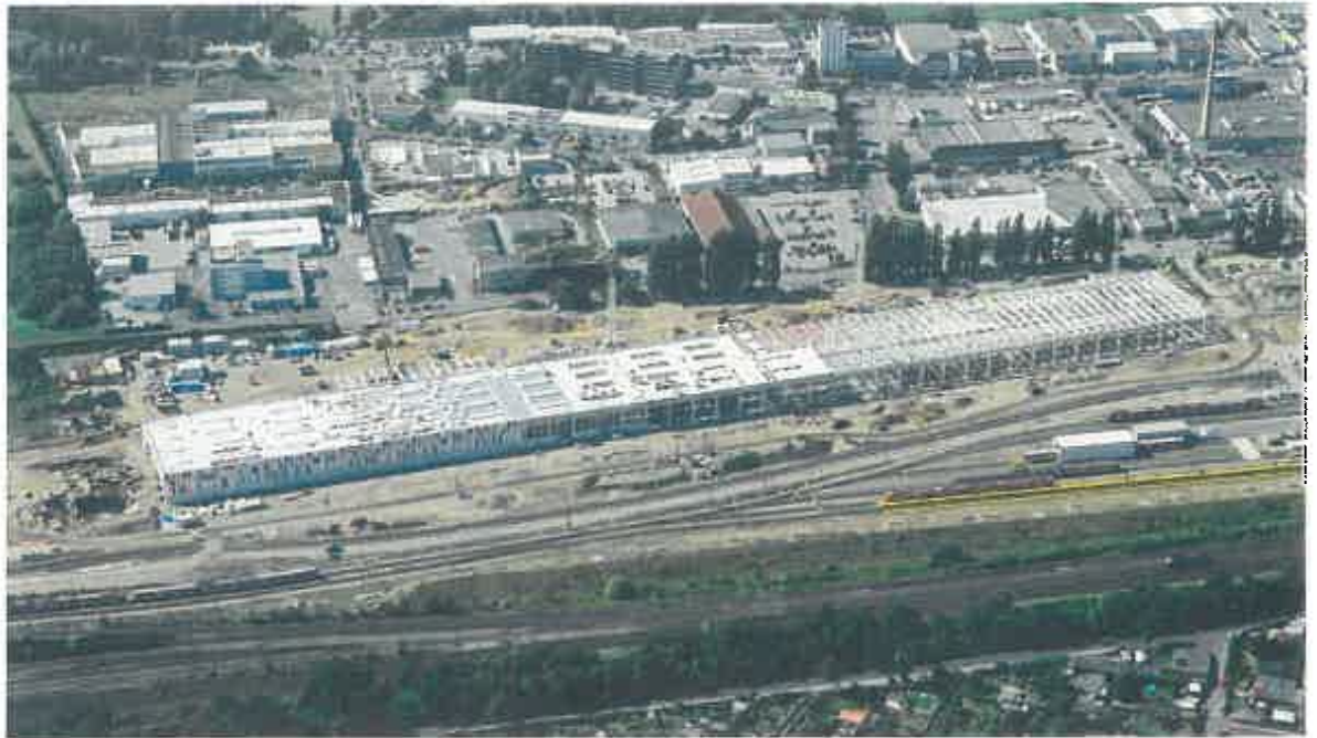
Bild 7: Bauzustand der ICE-Halle; links im Bild ist Eisenbahnüberführung zu erkennen (Foto: DB).
