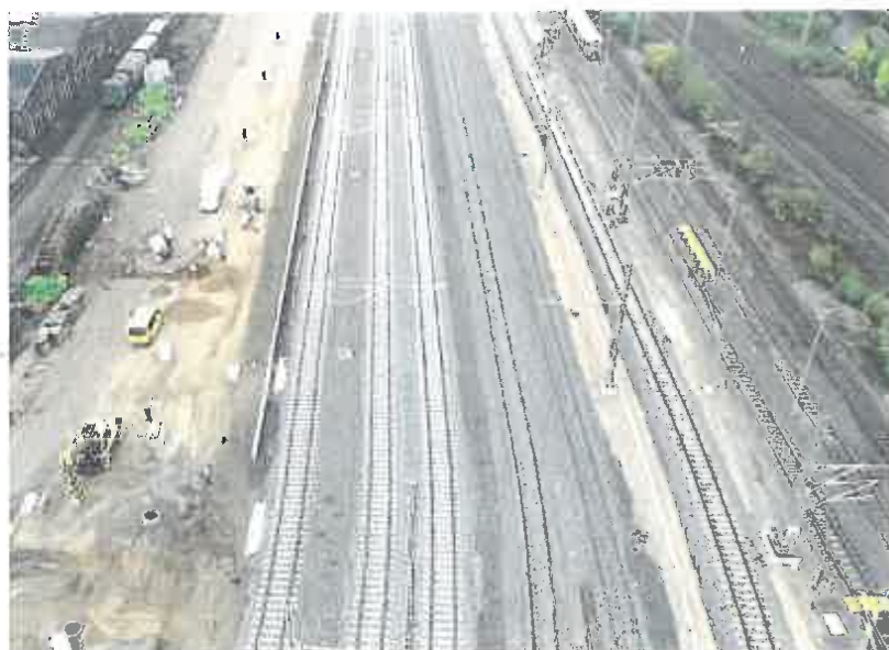
Bild 6: Bauzustand der Vorstellgruppe Nord (Foto: DB).
