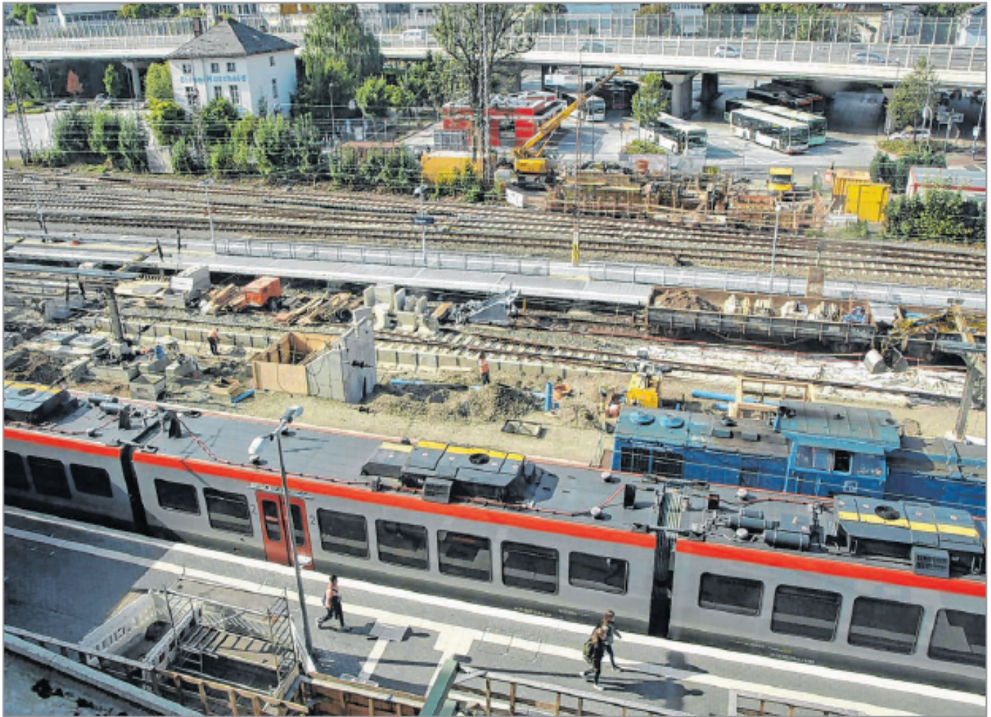
Ein Blick aus dem Hochhaus am Bahnhof gibt den Blick frei auf die Baustelle. Mitte 2017 soll alles fertig sein.
