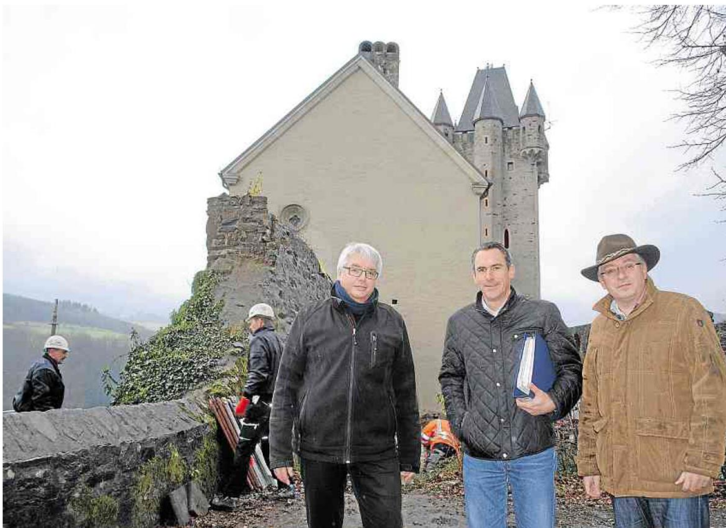
Stellen vor Ort die geplanten Sanierungen der Ringmauern der Burg Nassau in den nächsten drei Jahren vor (von links): Projektmanager Christoph J. Schiewek, Stefan Schuh vom Referat Landesbau des Finanzministeriums und Tragwerksplaner Christian Engels. Die touristische Nutzung soll so wenig wie möglich eingeschränkt werden.
